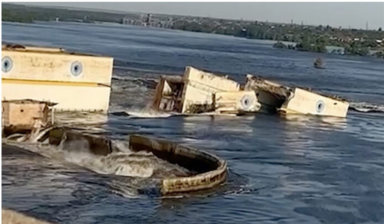
La diga danneggiata sul fiume Dnepr
